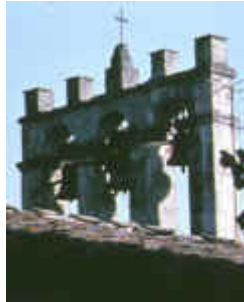
Il campanile a vela/the bell tower
